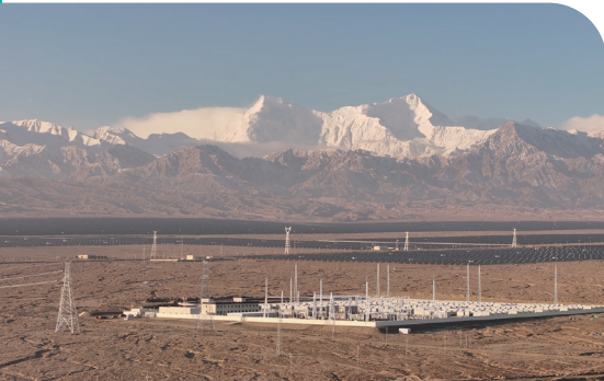
新疆克州300MW/1200MWh构网型独立储能项目 ——全球单体最大的磷酸铁锂构网型储能项目
